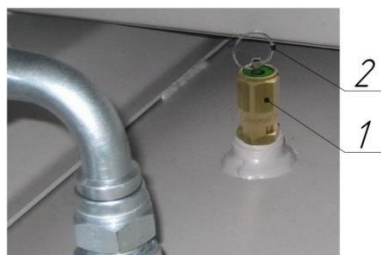
Рисунок 8 – Клапан предохранительный пружинного типа
