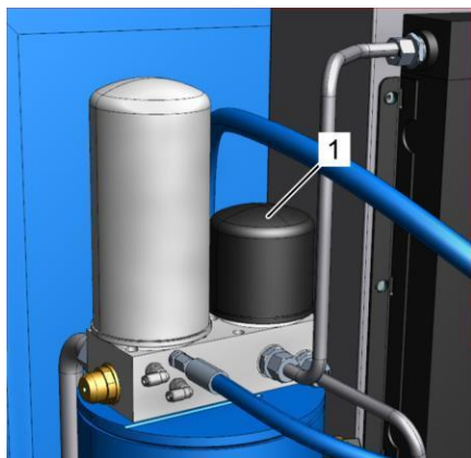
Рис. 22: Фильтр охлаждающей жидкости
